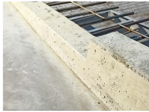
Różnice w kolorystyce powierzchni, porowatość
