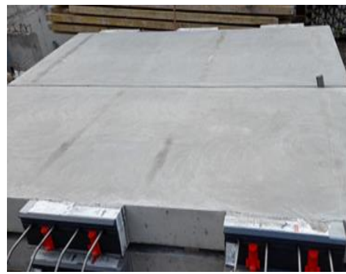
Ślady po podkładkach transportowych
