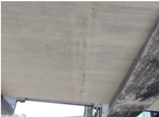
Ślady po podkładkach transportowych
